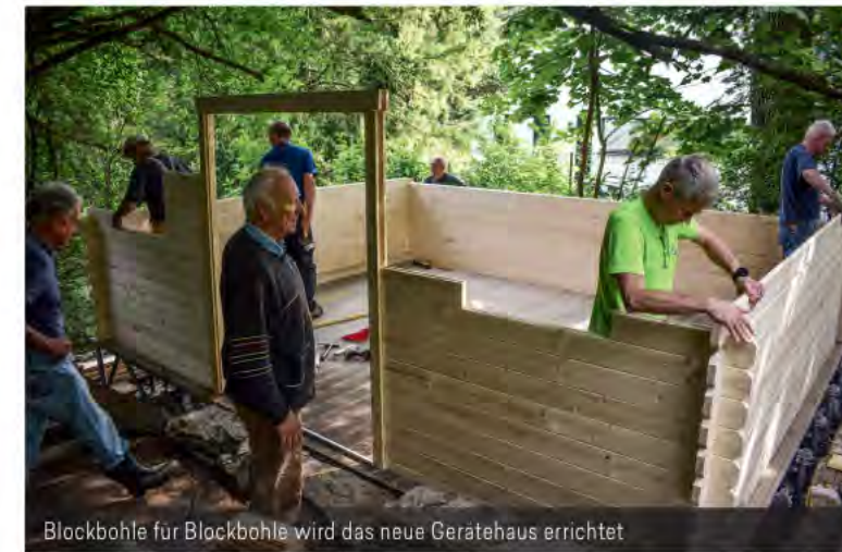
Blockbohle für Blockbohle wird das neue Gerätehaus errichtet
