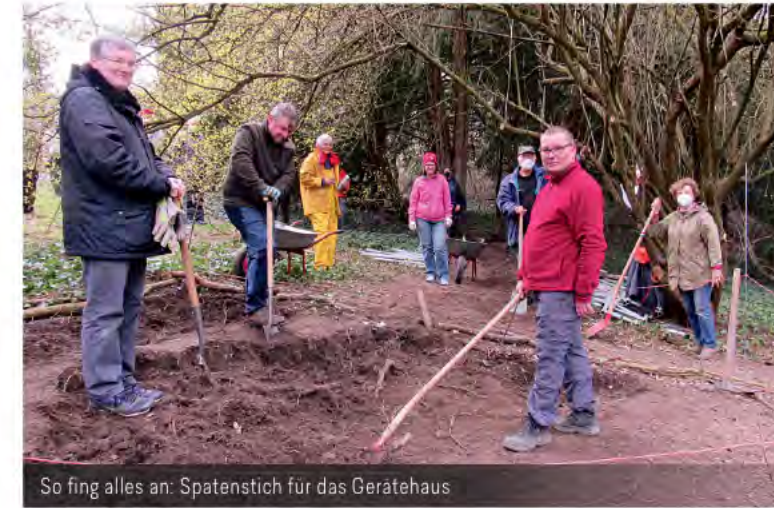
So fing alles an: Spatenstich für das Gerätehaus
