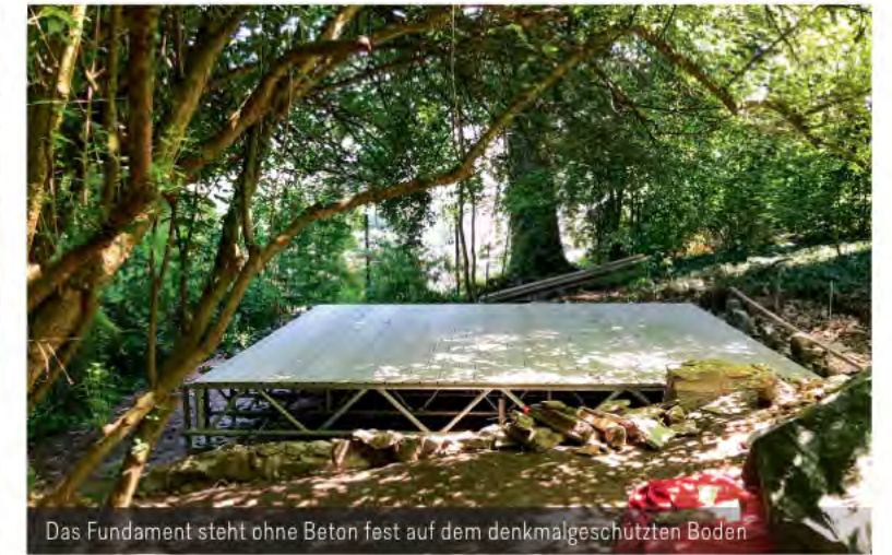
Das Fundament steht ohne Beton fest auf dem denkmalgeschützten Boden
