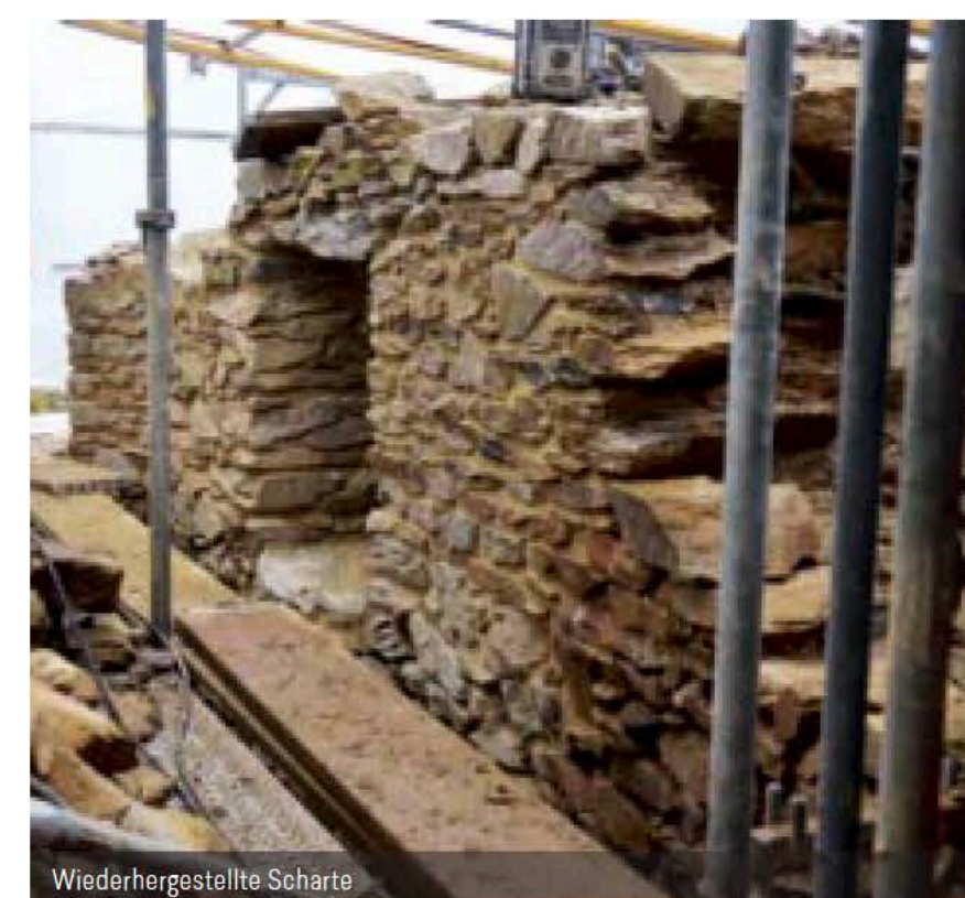
Mauerkopf aufgebaut
