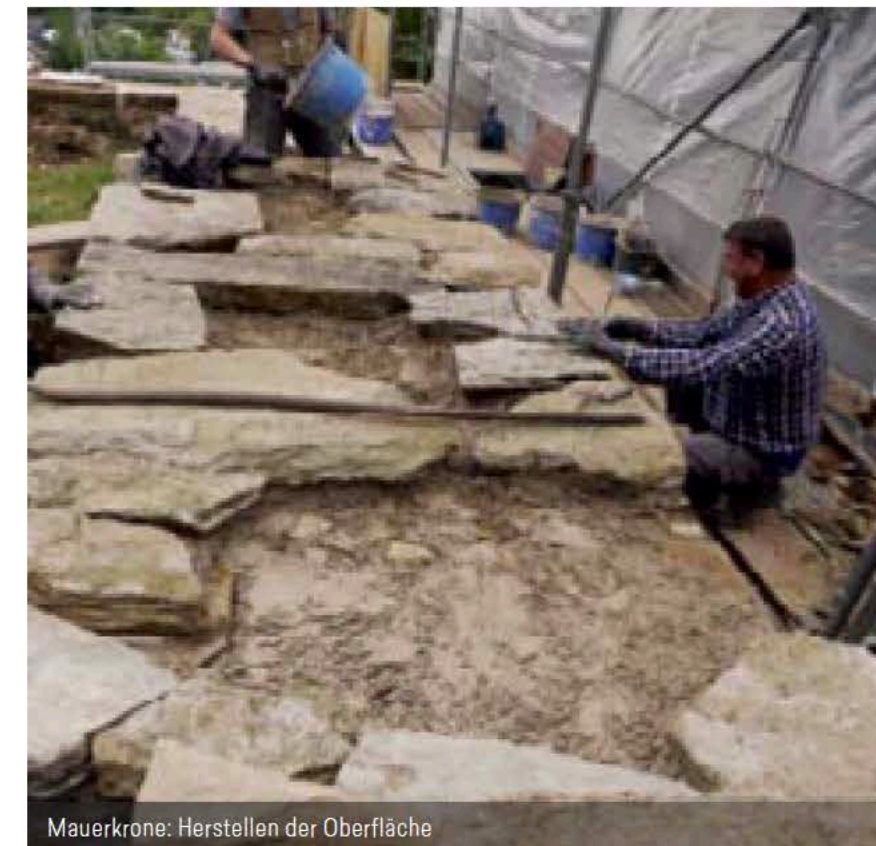
Mauerkrone: Herstellen der Oberfläche
